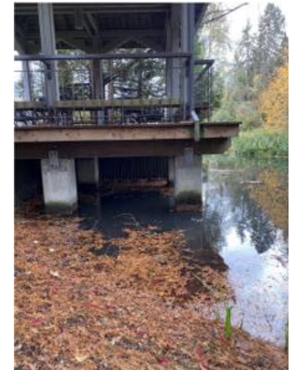
Siemens Pond Diversion (Nov 2021)
